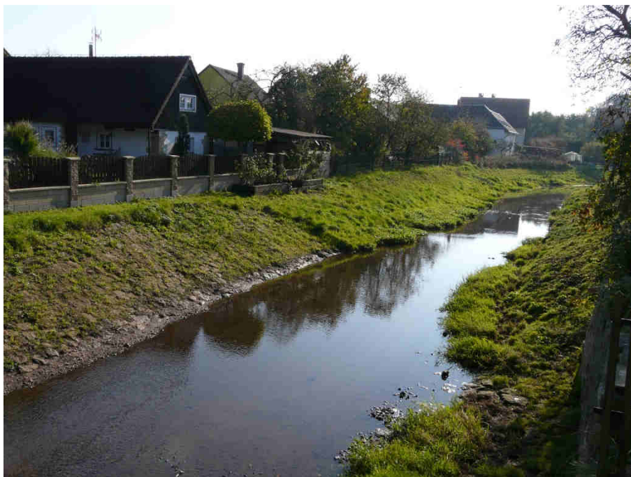
Dlažba z lomového kamene nasucho , s travním porostem na zachycené vrstvě náplavů. Vlevo je patrná plocha, z níž byly masivní náplavy nedávno odstraněny.
