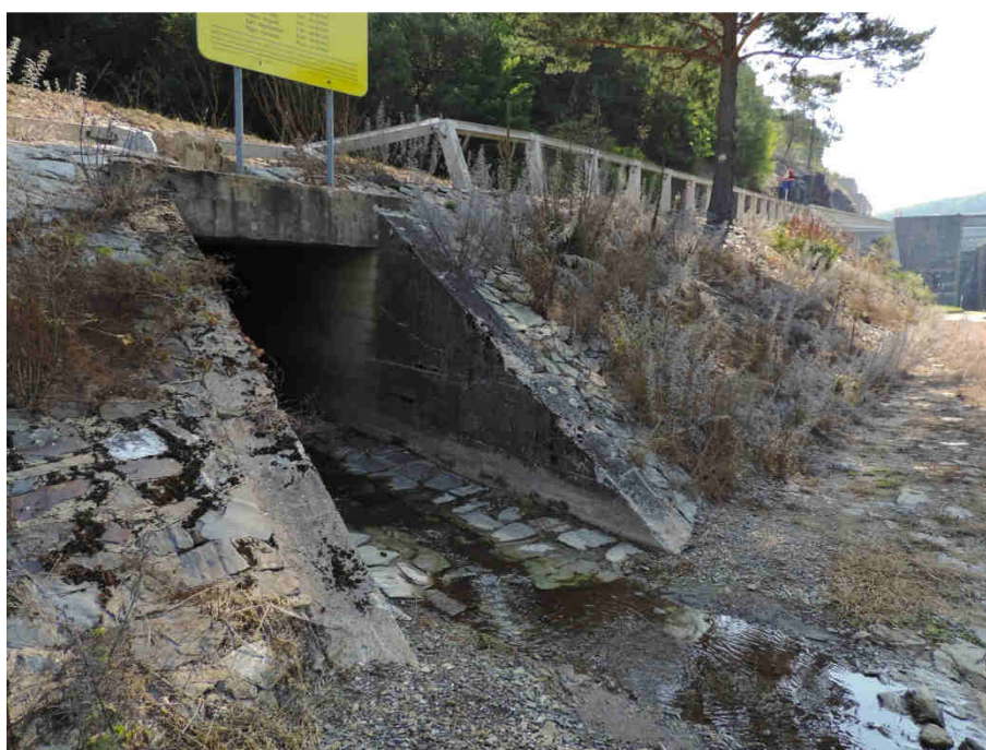
Dlažba s výplní spár cementovou maltou, stáří asi 70 – 80 let. Výplň spár začíná již být degradována a konstrukce prorůstá (zatím) bylinnou vegetací
