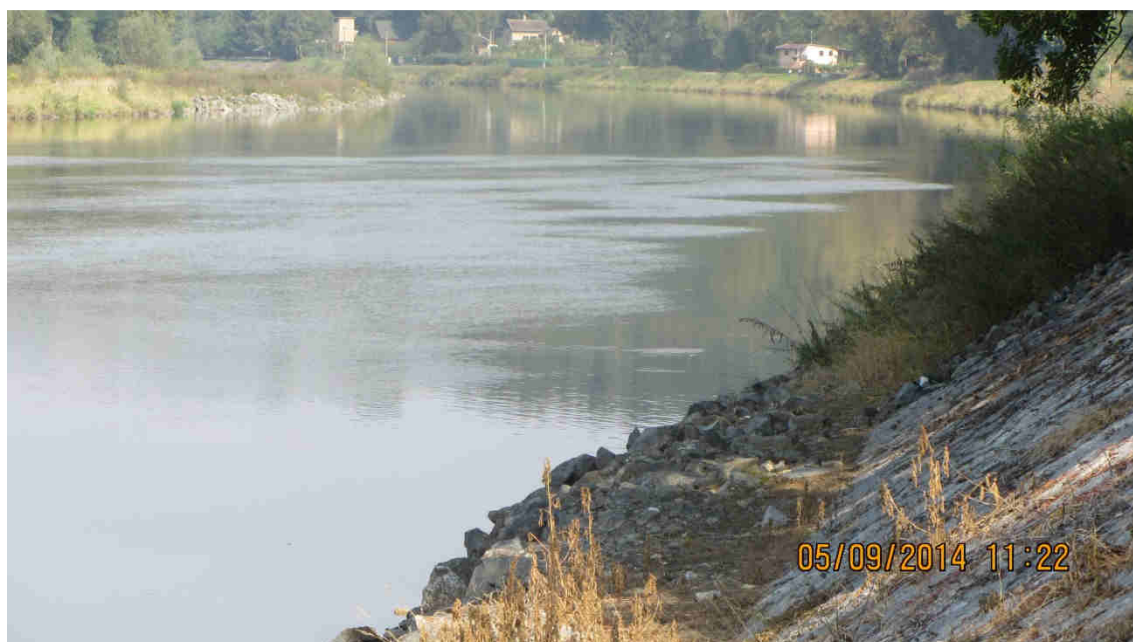
Dlažba z lomového kamene s výplní spár cementovou maltou, opřená o záhozovou patku. Stáří konstrukce asi 70 – 80 let.
